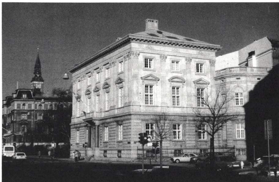
Carlsbergfondets bygning efter ombygningen 1976 og en senere facaderensning
